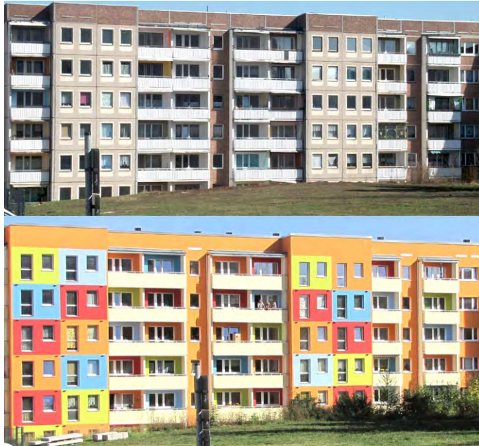
Die Blocks am Wacholderweg: vor und nach der Modernisierung
