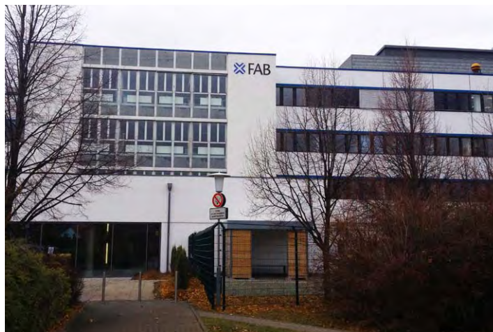
Das Hauptgebäude der X-FAB
